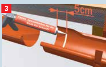
3 Med PREFA specialklæber påføres en ca. 8 mm tyk klæbestribe.
