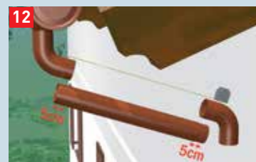
12 Afløbsrør til svanehals opmåles. Svanehalsen fastgøres i indhængningslasken på tudstykket med tråd.
