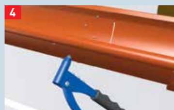
4 Med PREFA patentnitter 4 x 10 mm nitter i krydsstik - 6 stk. ved 25'er rende, 8 stk. ved 28'er og 33'er rende, 10 stk. ved 40'er rende, 20 nitter pr. søm ved PREFA skotrende.
