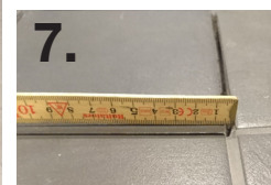
6. 7. fordel luft/spalte ligeligt omkring fliser/klinker.
