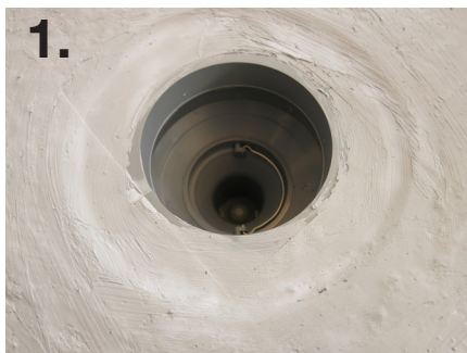
1. PURUS MultiFlex korrekt monteret jvnf. fabrikantens anvisninger.
