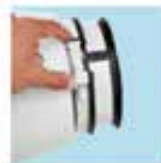
Monter ventilator enheden og stram spændebåndene
